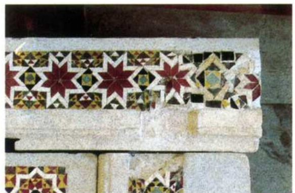
Connessione angolare tra elementi mosaicati in fase di assemblaggio in loco, all'interno della cattedrale.
